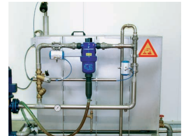
■ Nettoyage automatique (surpresseur + dosatron en options)
