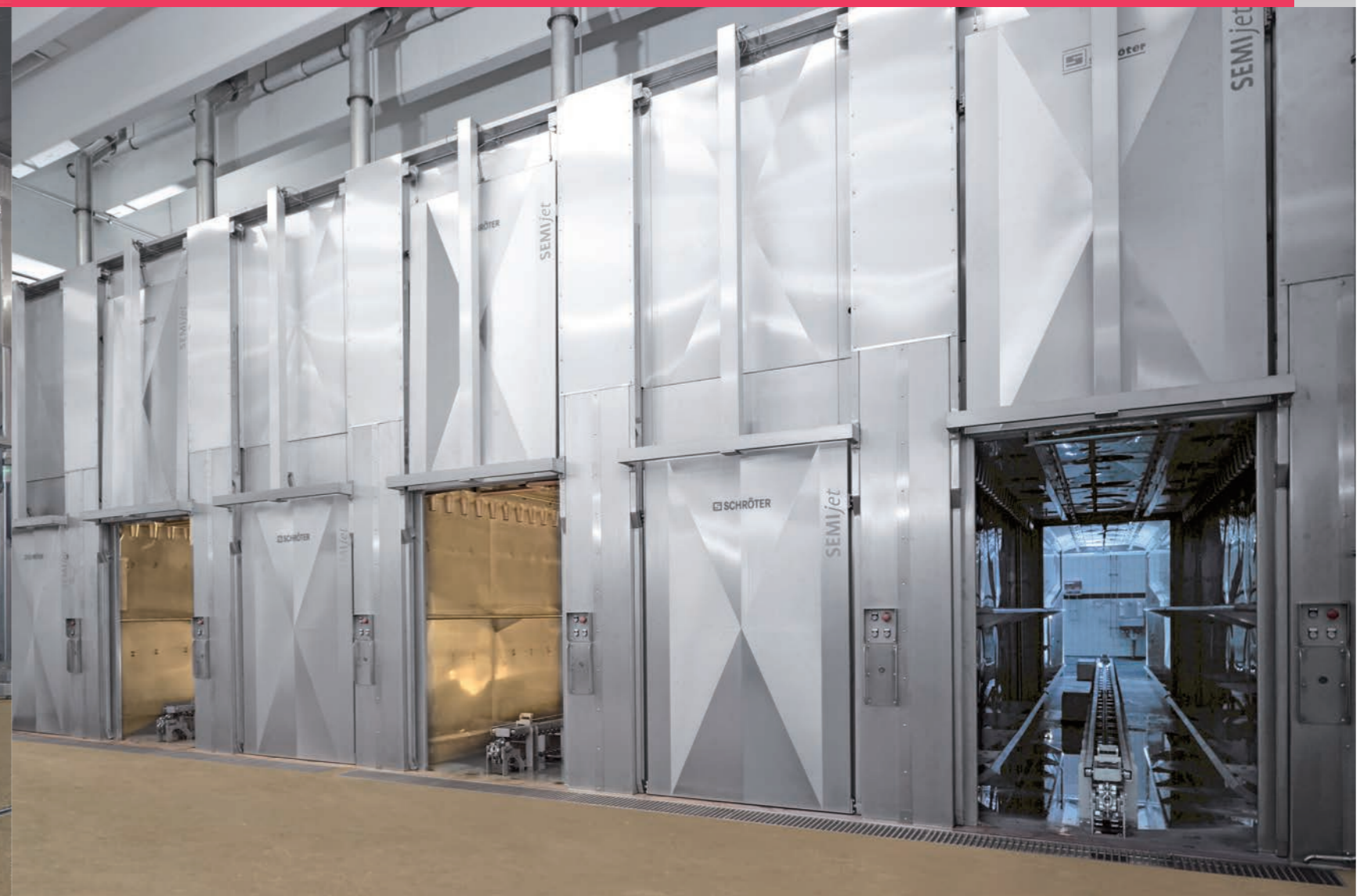
■ Cellules semi-continues munies d'une transitique avec chaînes à cliquets pour chariots sur roues
